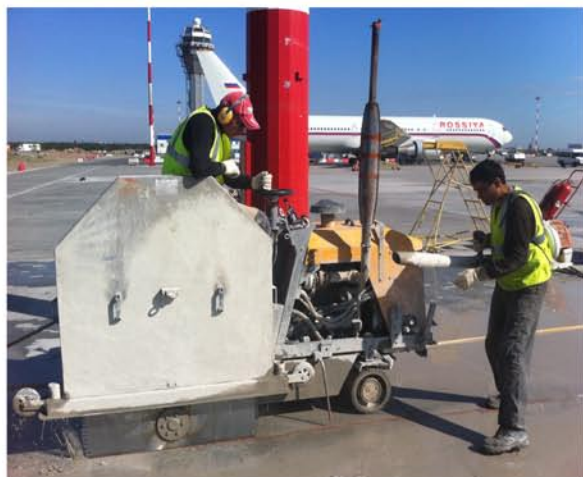
Нарезка деформационных швов, аэропорт Пулково, г. Санкт-Петербург
