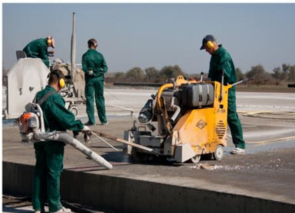
Нарезка деформационных швов при строительстве ИВПП, г. Энгельс
