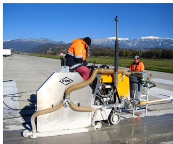
Строительство ВПП, аэропорт Адлер, Краснодарский край
